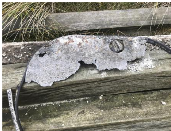
Inspectieluik van de brandstoftank. Foto: Reg Mulder
